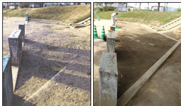
↑再生作業前の砂場。使われていない間に踏み固められ、草が生えてしまっていた。
