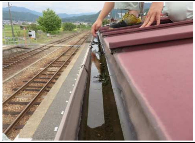
状 況：吊金物の破損による排水不良
