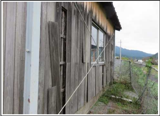
状 況：木外装材の著しい劣化
