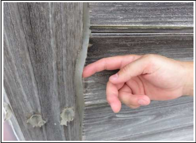
状 況：木外装材・シーリング材の経年劣化
