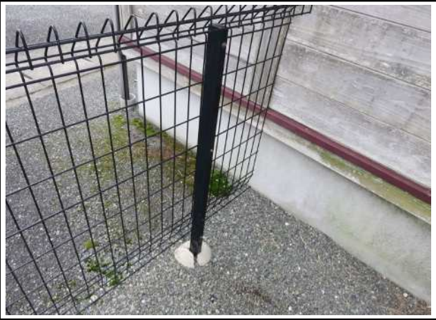
状 況：固定金具の発錆、基礎の破損
