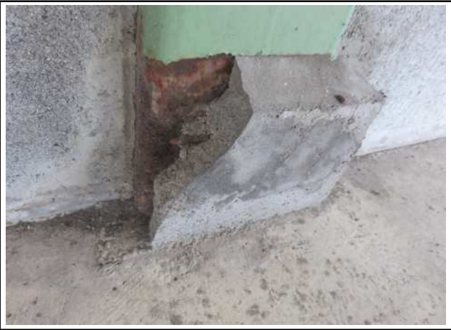
状 況：根巻部分の破損、鋼材の錆の発生
