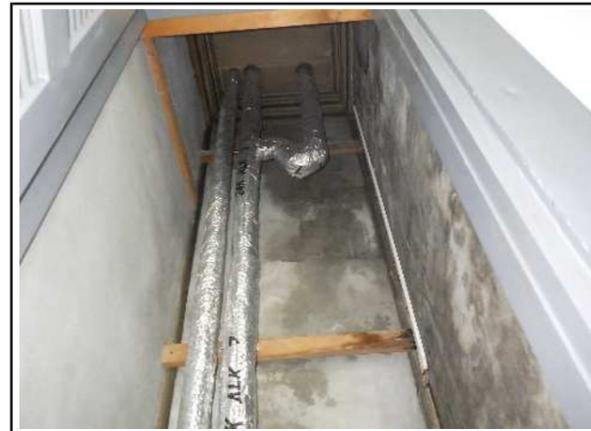
状 況 : 外壁からの雨水の浸入
