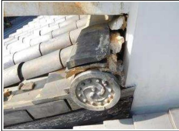
状 況 : 隙間の発生、雨水の浸入
