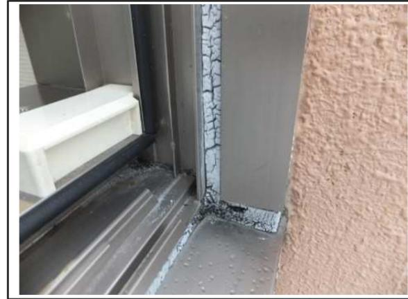
状 況 : 経年劣化による硬化・ひび割れの発生
