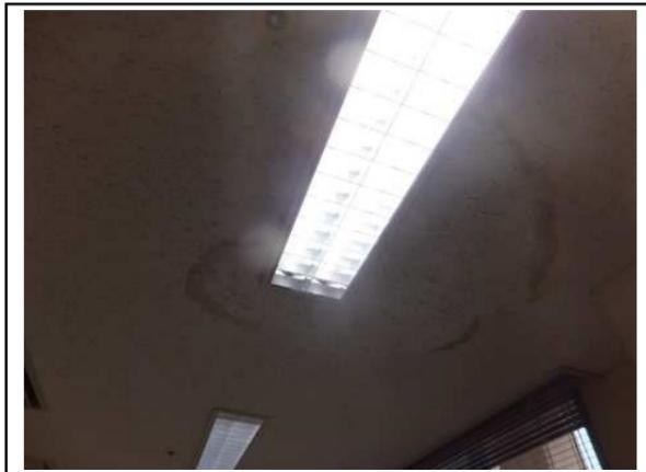
状 況 : 漏水による雨漏り跡(雨漏りは修繕済み)
