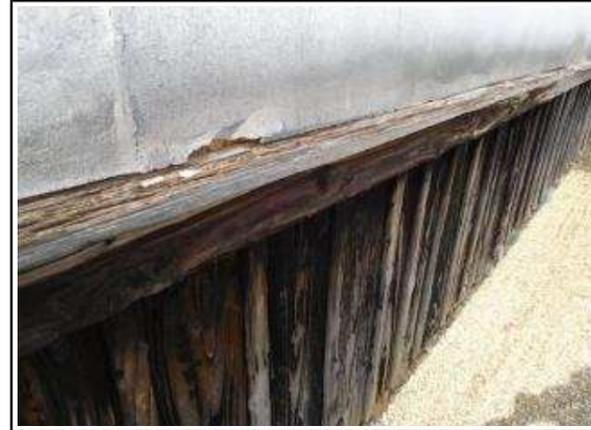
状 況 : 経年劣化による下見板の腐朽、漆喰の破損
