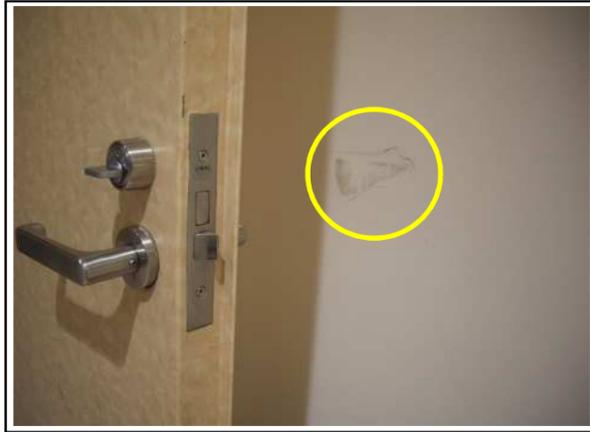
状 況 : 建具の衝突による壁仕上げ材の破損
