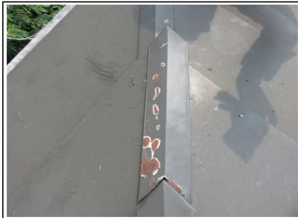
状 況 : 金属屋根の塗装剥離、発錆
