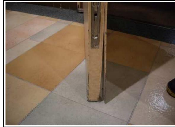
状 況 : 召合せ部の破損
