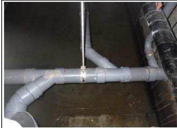
状 況 : 床下配管ピットに湧水の発生
