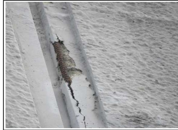
状 況 : 外壁の一部に鉄筋の爆裂の発生
