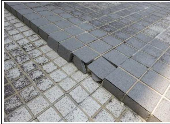
状 況 : 床タイルに浮き・破損が散見
