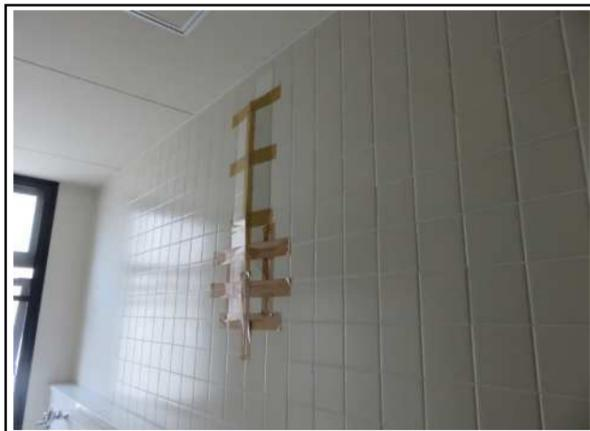
状 況 : 壁タイルの剥離による脱落の危険性
