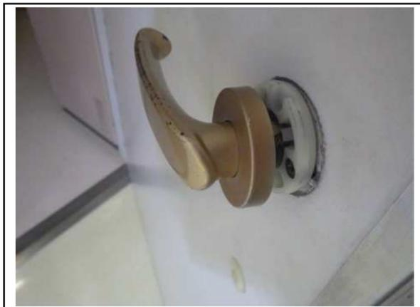
状 況 : 取手及び建具本体の破損
