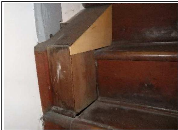
状 況 : 階段踏板が破損し、脱落の危険
