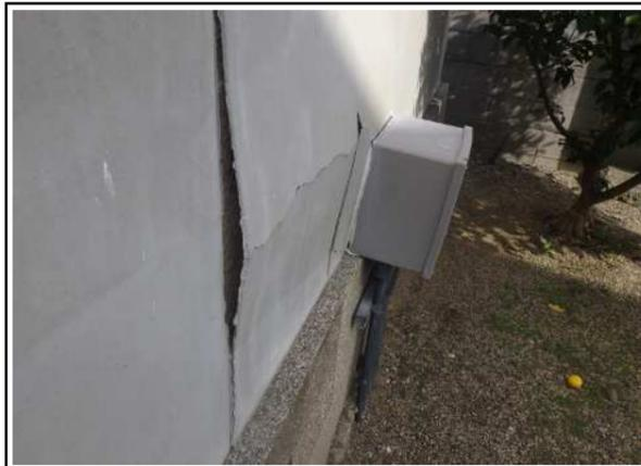
状 況 : 建物傾斜による外壁の浮き、剥落
