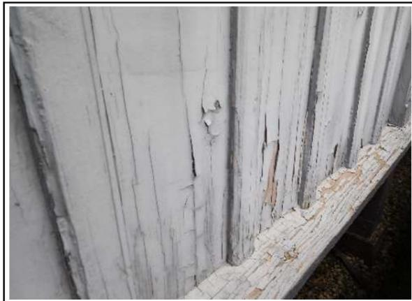
状 況 : 腰壁の経年劣化による塗装の剥がれ
