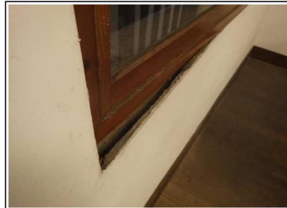
状 況 : 建物傾斜による内装壁の浮き
