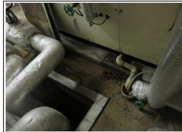
状 況 : ドレンパンの腐食による水漏れが発生
