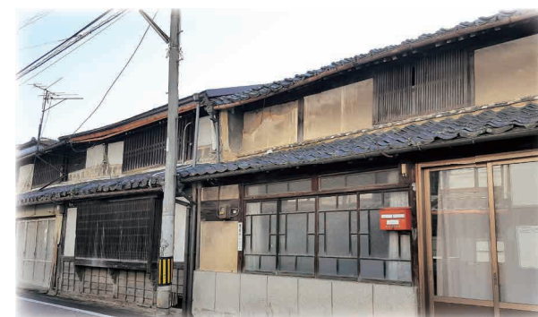
工事前の旧荻田家付属町家群（平成30年12月撮影）
