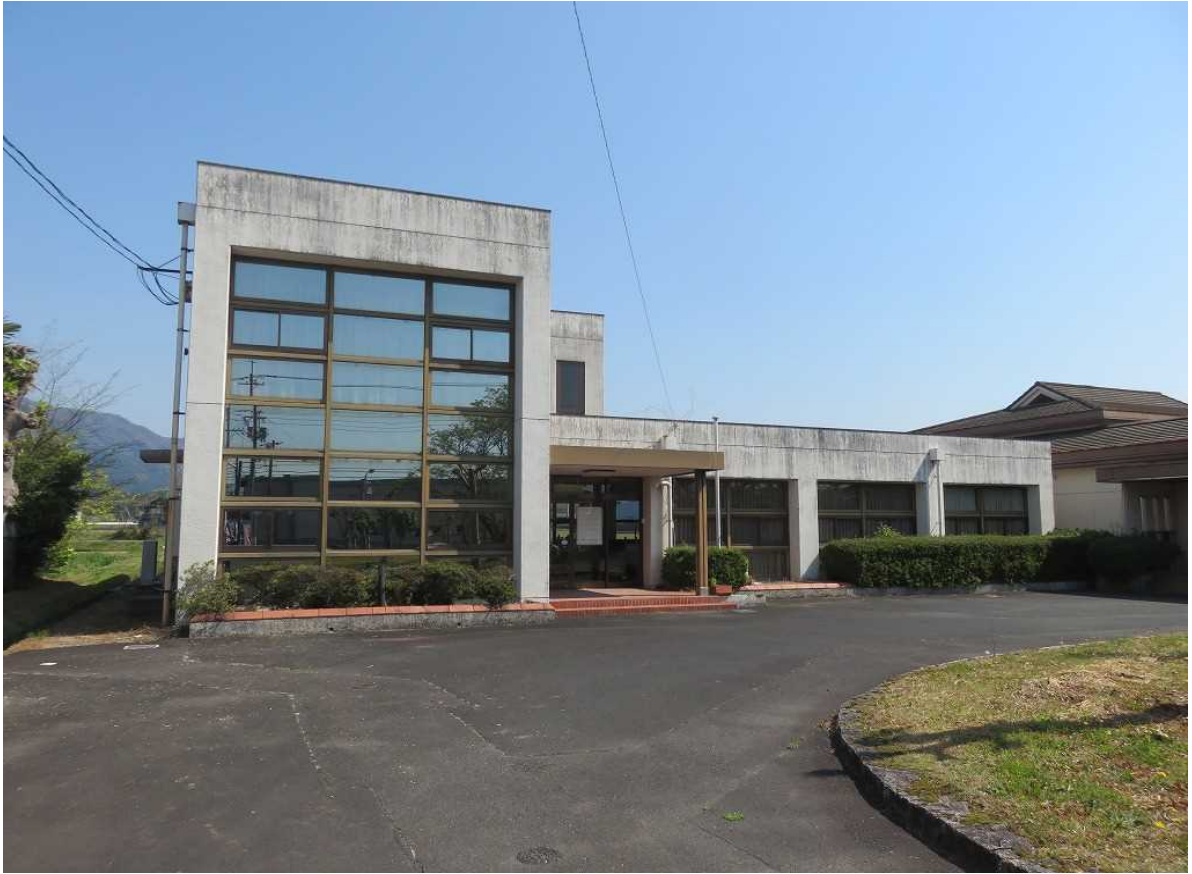
外観 南側の大きなガラスが特徴的な建物です。
