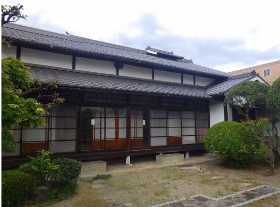
南側外観 建物廻りには庭園が広がっています
