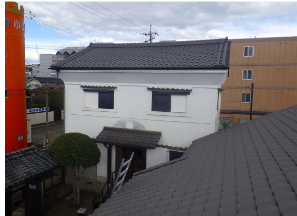
蔵 敷地内に2階建ての蔵が建っています
