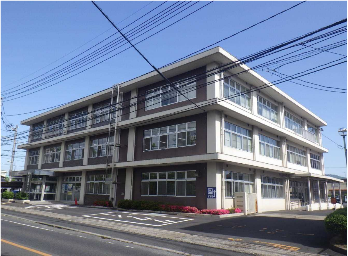
外観 南側からの全景。3階建ての庁舎です。
