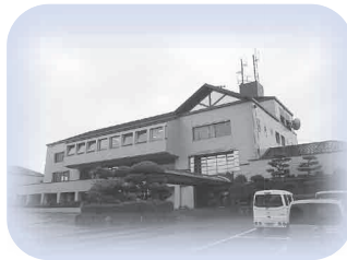
久米支所（昭和 63 年築）
