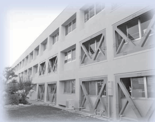
【西小学校（平成21年度に耐震化）】
