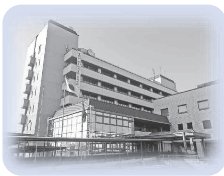
【市役所本庁舎（昭和57年築）】
