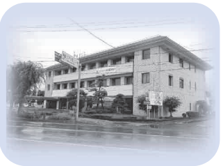
勝北支所（昭和 60 年築）
