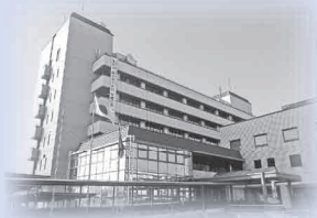
本庁舎（昭和 57 年築）
