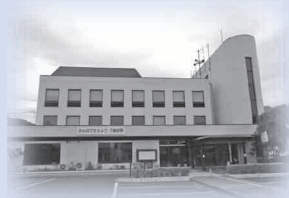
加茂支所（昭和 55 年築）
