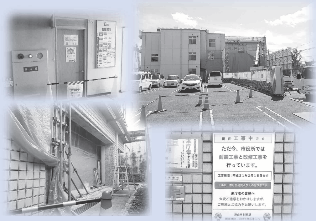
【本庁舎・東庁舎耐震化工事・長寿命化工事の様子】
