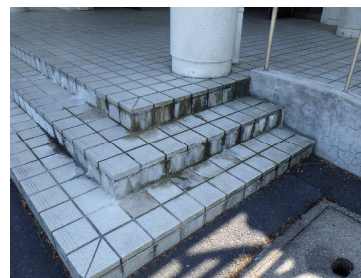
部位: 玄関前通路
