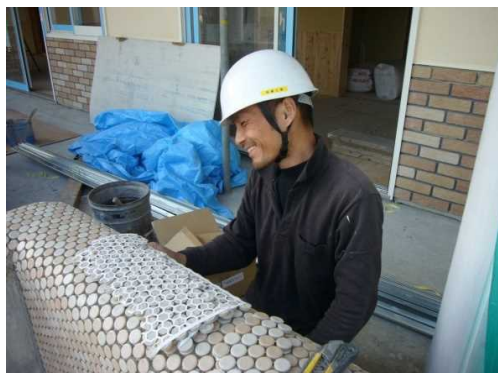
タイルの下地にもモルタルが塗られます
