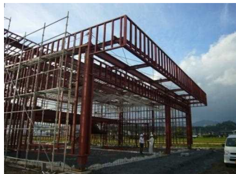
鉄骨造の建築現場
