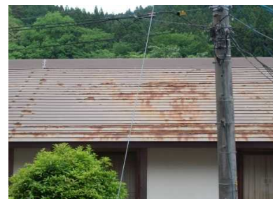
金属屋根(トタン屋根)に発生した錆
