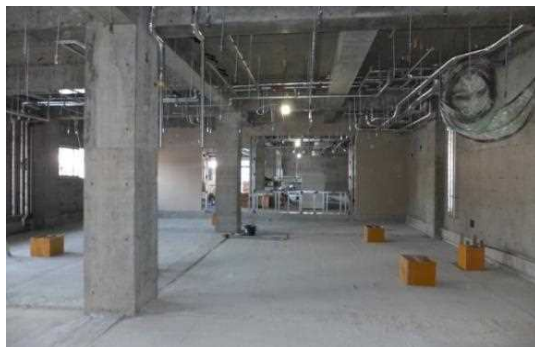
鉄筋コンクリート造の建築現場
