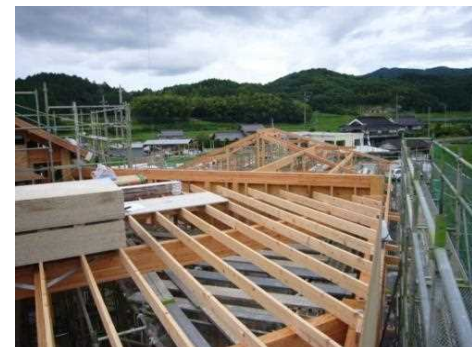
木造の建築現場
