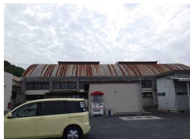
金属屋根(トタン屋根)に発生した錆
