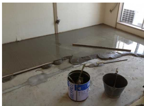
コンクリートの上にモルタルが塗られている様子
