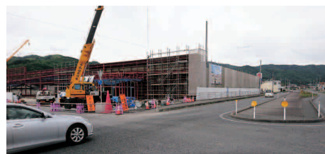
津山バイパスに建設中の大型スーパー
