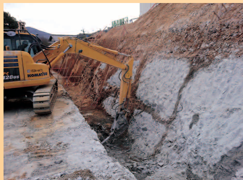
建設予定地の高い位置から強固な岩盤が露出
