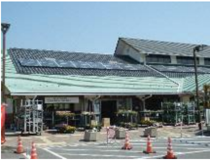
道の駅久米の里に設置された 市民協働発電所
