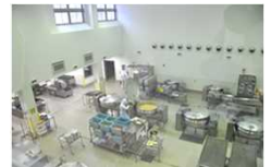
戸島学校食育センター調理室
