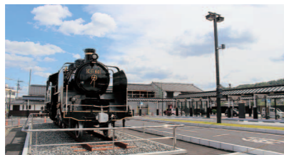
完成が近づく津山駅周辺整備
