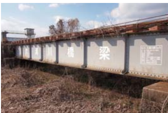
2-① 大溝川橋梁
