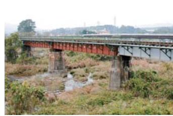
3-③ 第2吉井川橋梁
