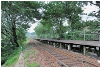
10-① プラットホーム01
