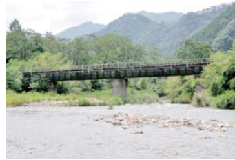
5-③ 第2加茂川橋梁
