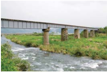
5-① 加茂川橋梁
