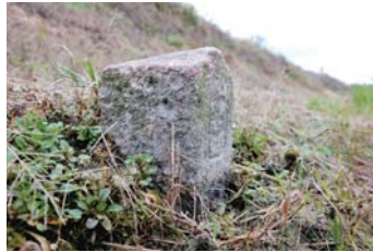
5-② 第 2 河原開渠付近
