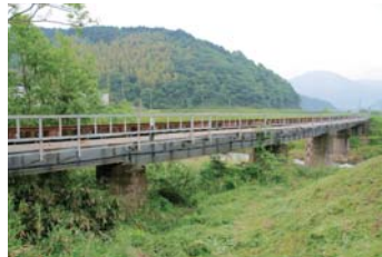
5-⑤ 第1加茂川橋梁
