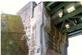
3-① 第21架道橋
