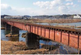
3-① 吉井川橋梁
