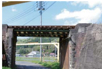
1-③ 第21架道橋
