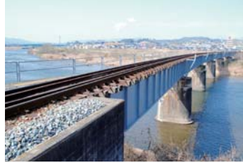
3-② 第1吉井川橋梁
