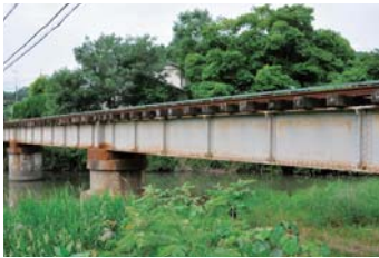
1-② 第2佐良川橋梁
