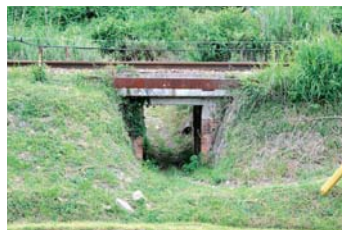
3-② 第8避溢橋
