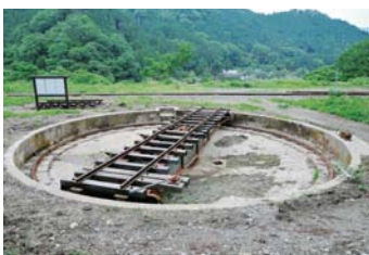
4-① 美作河井駅 40ft 転車台
