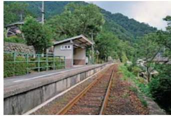
10-② プラットホーム02
