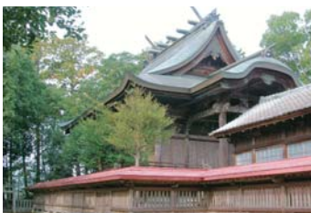
5-① 鶴山八幡宮本殿
