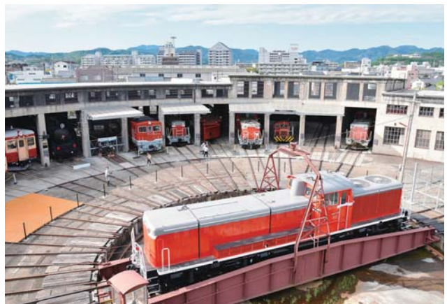
旧津山扇形機関車庫
