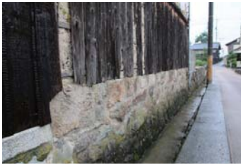
5-① 城東地区の民家の基礎石垣
