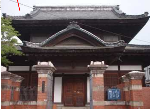
本館正面(改修前)
