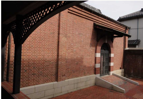
展示棟(改修前)
