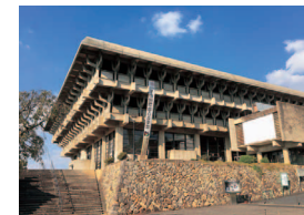
耐震化が予定されている文化センター
