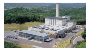
平成28年3月から本格稼働している クリーンセンター
