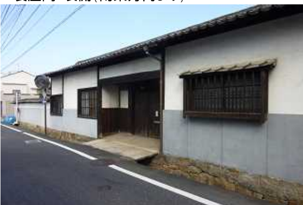
長屋門・表側(南東方向より)
