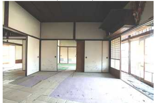
母屋内部・居間(西方向より)
