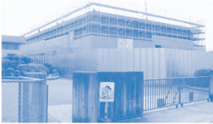
校舎耐震化による建て替え工事中の津山市立東小学校
