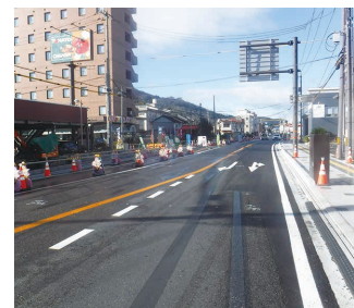
国道53号(昭和町)
