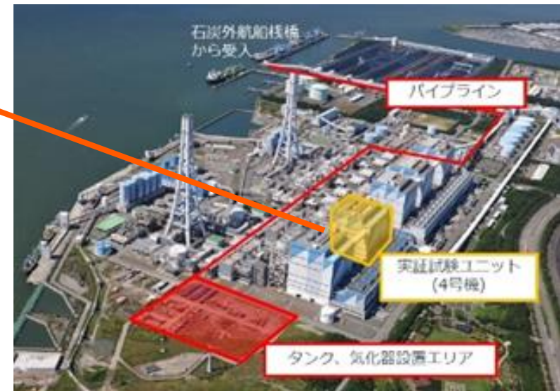
碧南火力発電所外観
