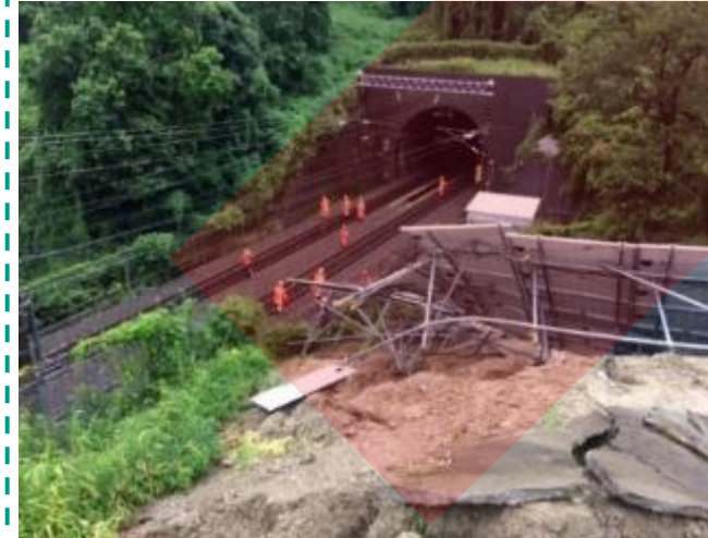
新幹線近くの斜面上部に設置された太陽光発電施設が崩落した事例 ※いずれも、環境省「太陽光発電の環境配慮ガイドライン」より
