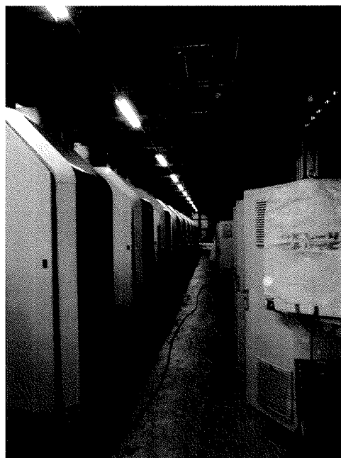
づらりと並んだボルター発電施設
