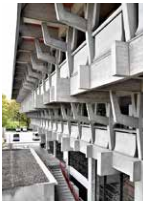
屋根を支える斗拱構造
