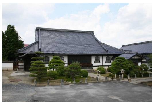
国の重要文化財 本源寺本堂
