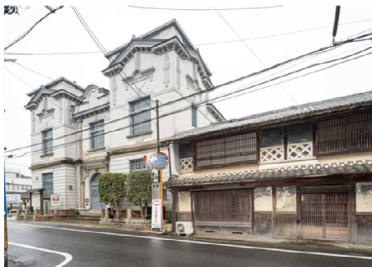
津山市城西伝統的建造物群保存地区
